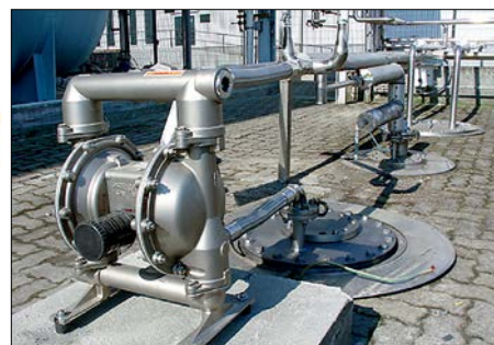
Pompe à membrane 1 1/2" (38,10 mm) installée dans une usine de traitement chimique et permettant le transfert du chlorure de méthylène
