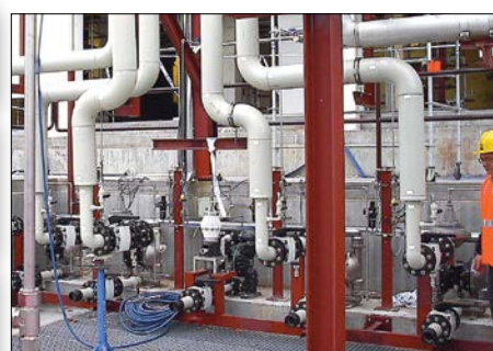
Pompes à membrane en acier inoxydable 2" (50,80 mm) assemblées avec des antipulseurs en PVDF, utilisées pour pomper de l'acide fluorhydrique
